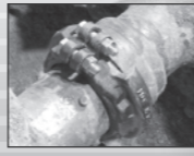
T形管路への取付(150mm)
