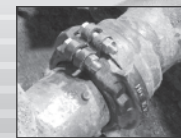
T形管路への取付(150mm)
