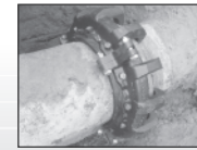
K形管路への取付(450mm)
