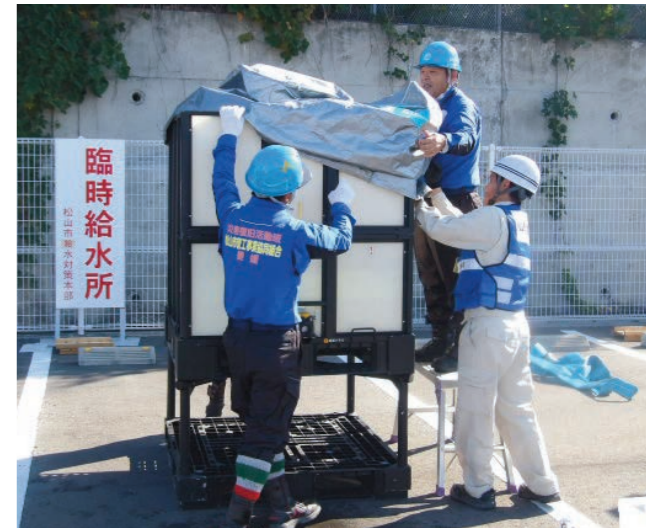
組立式タンク設置
