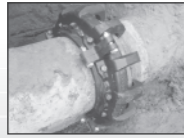
K形管路への取付(450mm)
