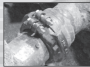
T形管路への取付(150mm)
