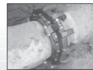
K形管路への取付(450mm)
