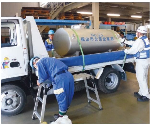
資機材積み込み
