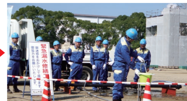
▲給水管 修繕後
